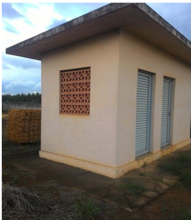
Figura 05 - Casa de Química Distrito Industrial II
