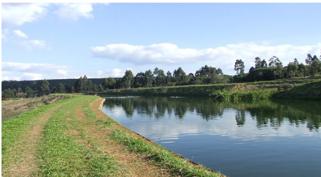
Figura 10 - Lagoa de estabilização da ETE
