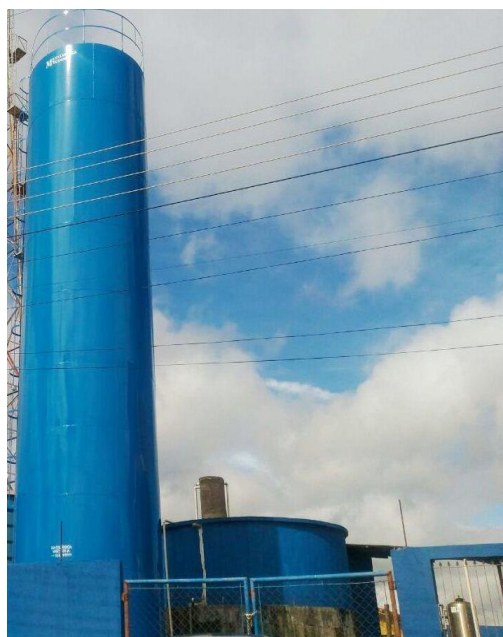
Figura 03 - Reservatório R3 - Remonta
