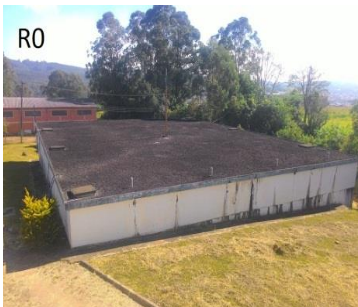
Figura 02 - Reservatório R0 - ETA Matarazzo
